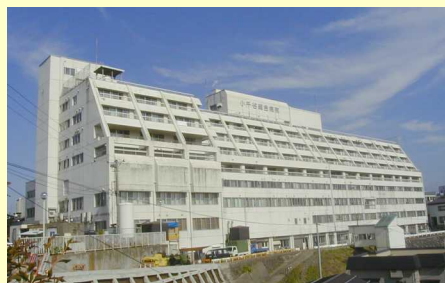
小千谷総合病院全景
